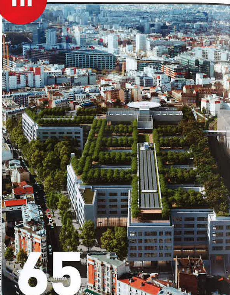
Source : Reno Piano Building Workshop, Brunet Saunier Associés.
